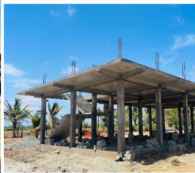
Beheerderswoning in aanbouw
