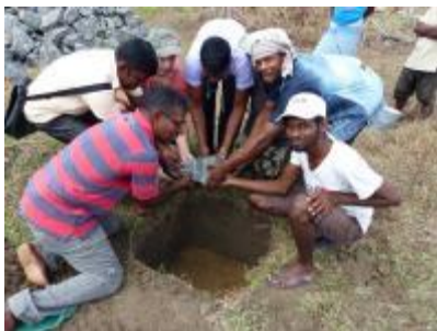
1 e steenlegging huis
